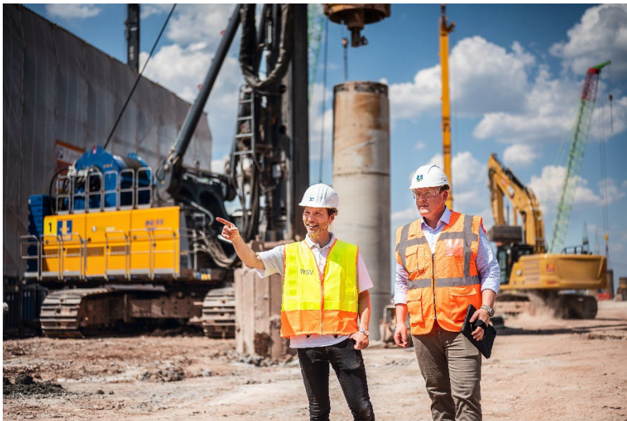
(3) V.l.n.r.: Andreas Beier (Projektleiter und Baubevollmächtigter, Wasserstraßen-Neubauamt Aschaffenburg) und Andreas Hertenberger (Projektleiter, BAUER Spezialtiefbau GmbH)
